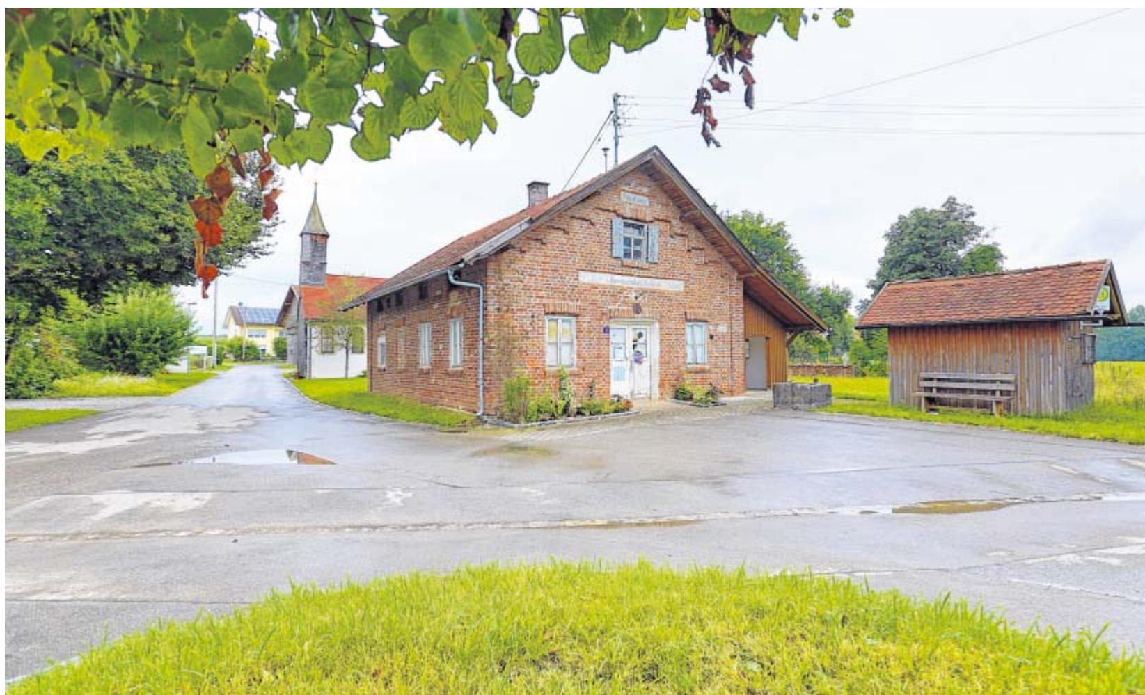
Ein Dorf soll schöner werden: Neben den Ortsstraßen in Irpisdorf wird auch die Dorfmitte bei der Kapelle neu gestaltet.
