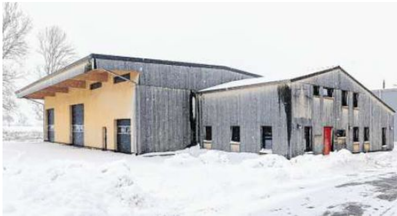
In dem Gebäude der ehemaligen Schreinerei soll das Feuerwehrgerätehaus Platz finden.
